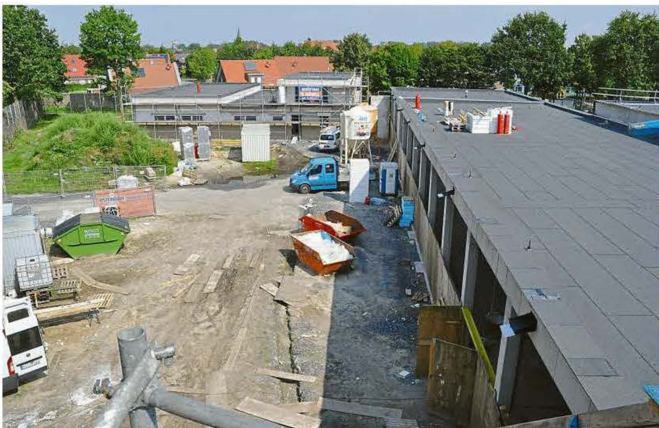
Aus der Vogelperspektive wird gut deutlich, wie groß die neue Feuerwache Telgte an der Alverskirchener Straße dimensioniert ist.
