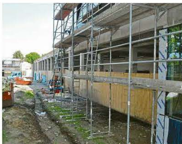
Mit einem Bretterverschlag sind die zukünftigen Tore der Feuerwache geschlossen.
