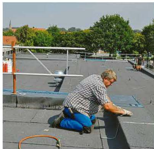
Mit Teerpappe wird derzeit das Dach der neuen Feuerwache von Facharbeitern abgedichtet.
